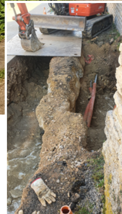
Enfouissement de la fibre, des lignes téléphoniques et des lignes électriques rue de l'Église.
