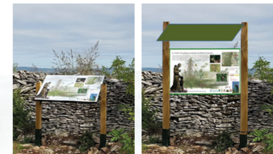
Nouvelle installation pour préserver les panneaux des rayons du soleil.
